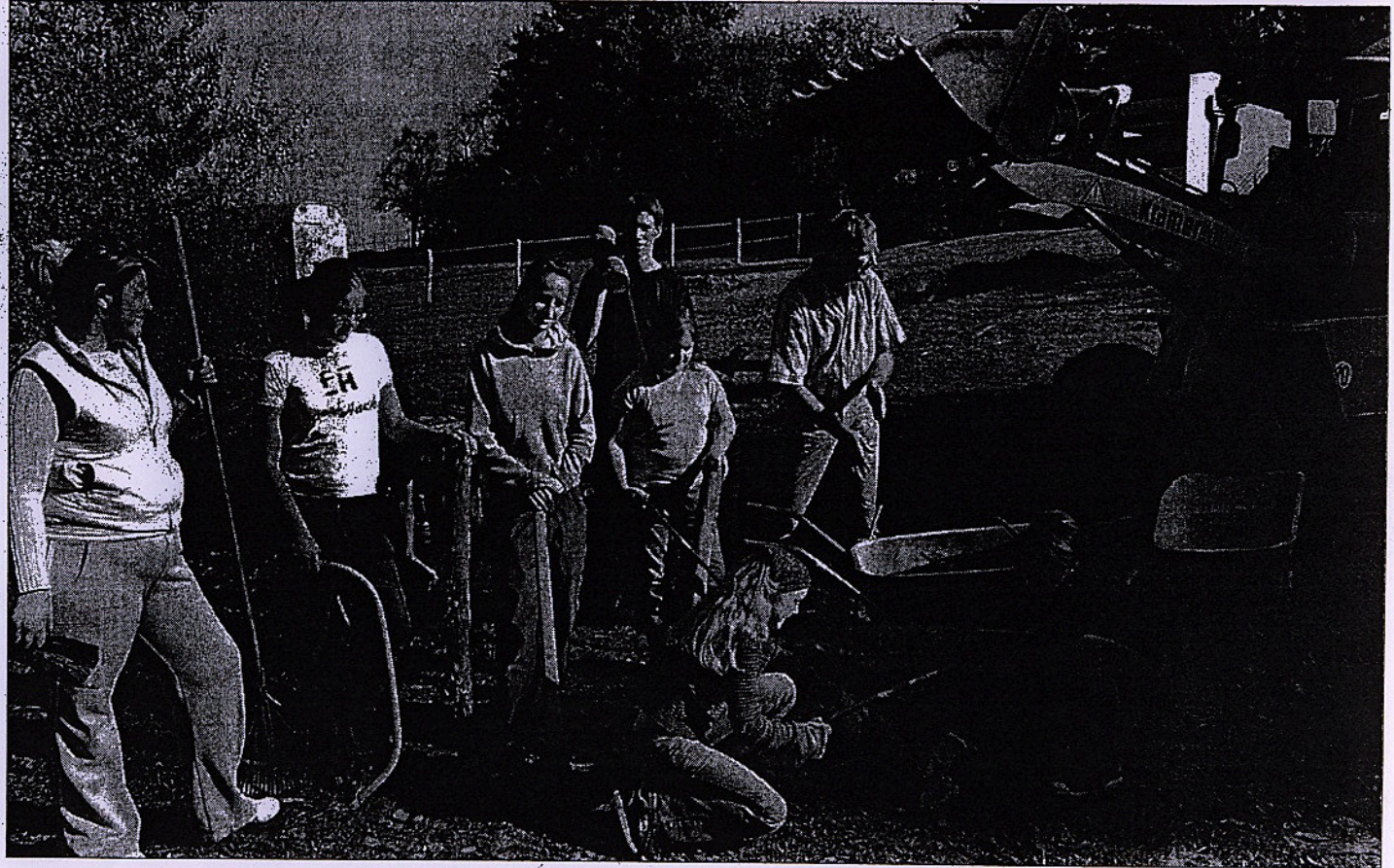
In Walberberg haben die Arbeiten an dem Seilgarten begonnen, in dem Jugendliche Teamerfahrung sammeln sollen. (Foto: Homey)
