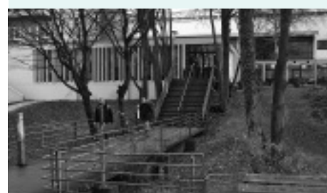
Die „Brücke“ zwischen Haupthaus und den Bungalows: hier erfolgt die Betonsanierung und die Überdachung dieses Bereichs
