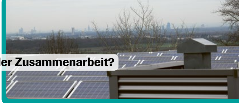
Der Blick geht bei gutem Wetter über die Dächer der Jugendakademie Richtung Köln bis zum Dom
